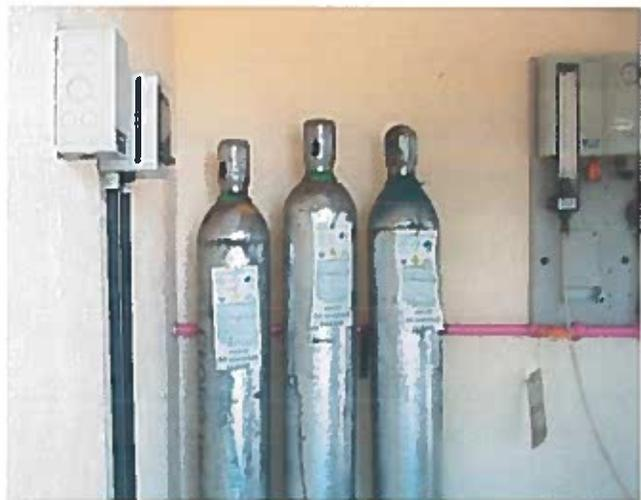
6.16-01 Cilindros de gas cloro alejados de fuentes de calor
