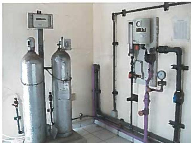
6.17-06 Cilindros de 68 kg pesados y encadenados
