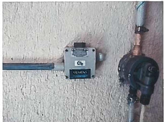
6.3-05 Sistema de detección de fugas de gas cloro
