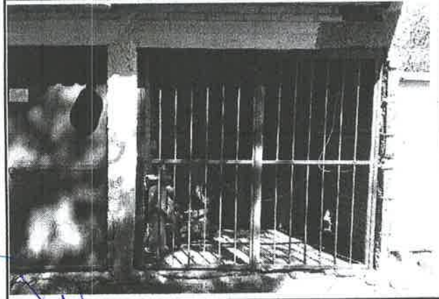
FOTO CASETAS DE CONTROLES
