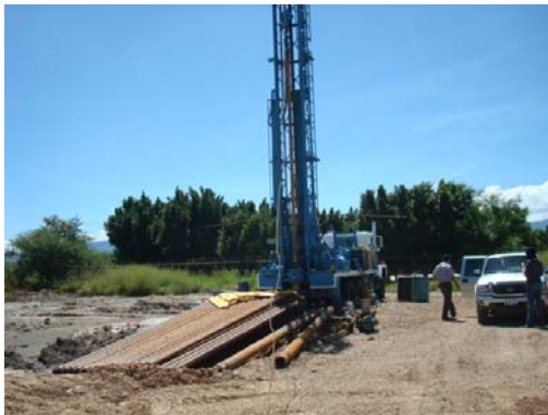
Figura n° 11. Perforación del nuevo pozo en la Unidad Deportiva
