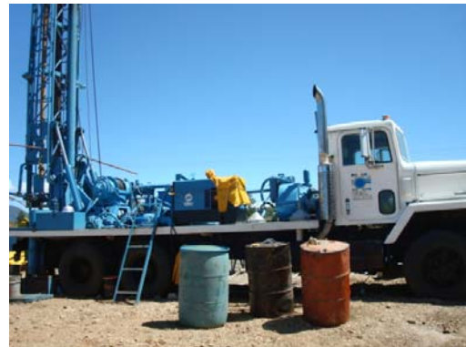
Figura n° 11. Perforación del nuevo pozo en la Unidad Deportiva
